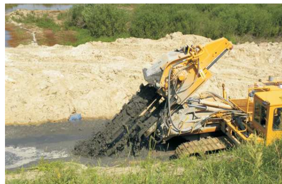
Trencher, wykonujący przegrodę metodą CDMM
