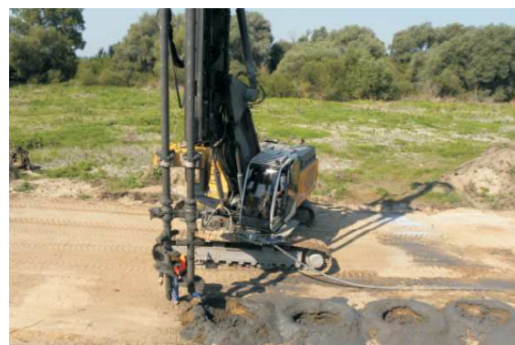
Wykonywanie przegrody metodą wgłębego mieszania - metoda DMM
