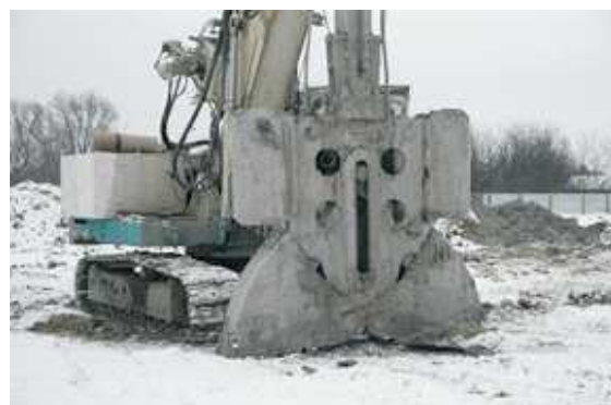
Wykonywanie przegrody metodą krokową.
