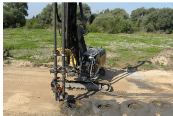
Wykonywanie przegrody metodą wgłębego mieszania - metoda DMM
