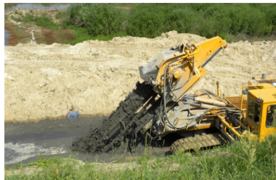
Trencher, wykonujący przegrodę metodą CDMM
